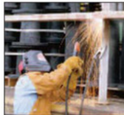
Soldadura de Electrodo Revestido con CD
